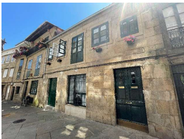
Fachada rúa Travesa, acceso centro de día
